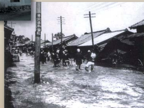
明治40年の大水害で浸水した石和宿『笛吹市風水害誌』より
